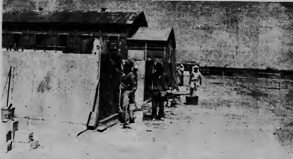
Un bista riba e localidad riba terreno di Eagle, den cual e obreronan di werkverschaffing ta hanja les di mesia y carpinte.
